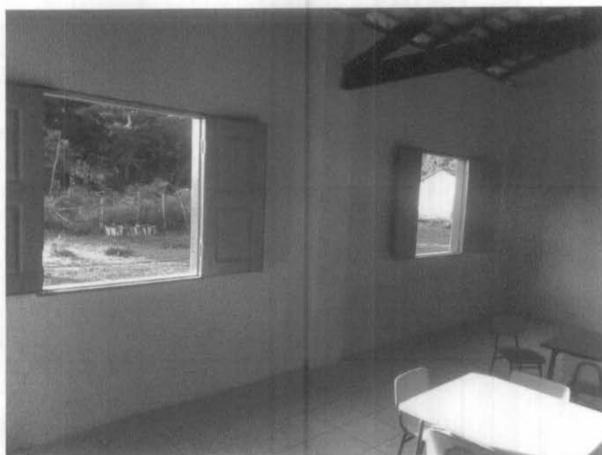
Imagem 02 – Reposição de janelas de madeira da fachada
