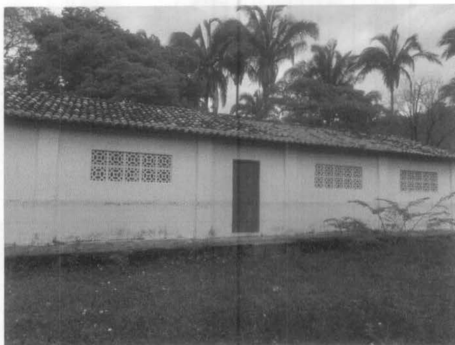
Imagem 04 – Fachada Frontal da U.E
