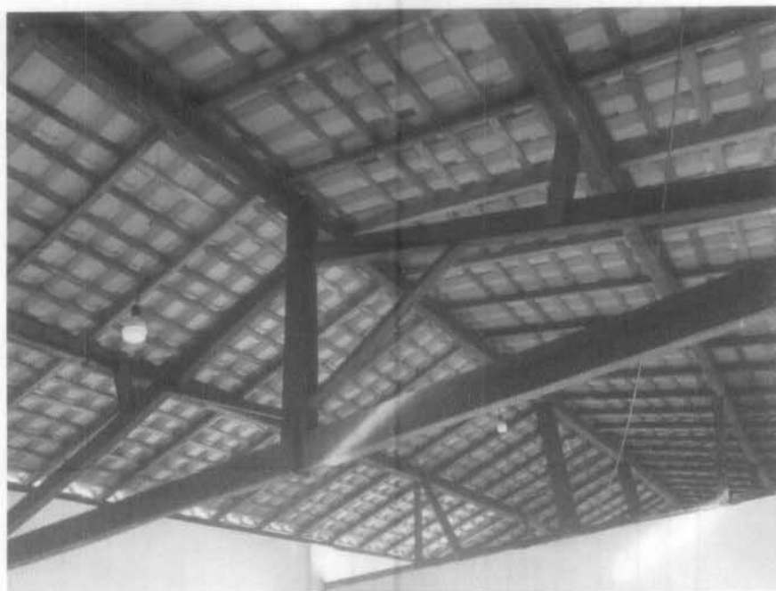
Imagem 01 – Execução de trama de madeira, imunizada, e telhamento com telha cerâmica capa-canal
